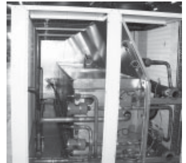
Caisson d'isolation phonique du compresseur
