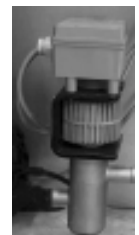
Elektronische expansiekleppen
