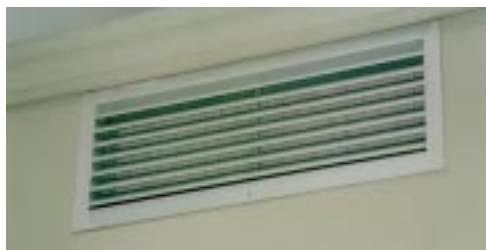
Abb. D – Äußeres, kontrollierbares Regenschutzgitter mit Vorfilter
