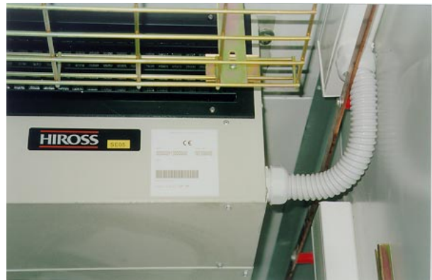
Abb. F – Detailansicht der elektrischen Anschlüsse an SE mit Kabelpresse und Kunststoffhülse (nicht bei uns geliefert).
