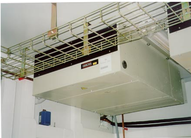
Fig. A – Equipo de evaporación SE
