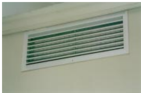
Fig. D – Rejilla exterior de protección contra la lluvia inspeccionable con prefiltro
