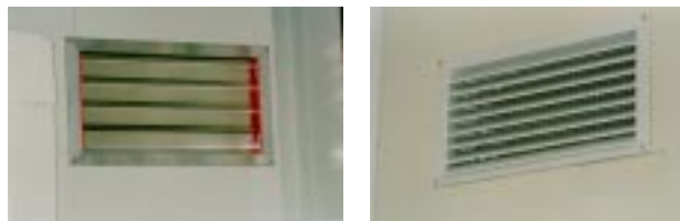
Fig. E – Compuerta interior de sobrepresión con apertura de las aletas hacia el exterior y rejilla exterior de protección contra la lluvia.
