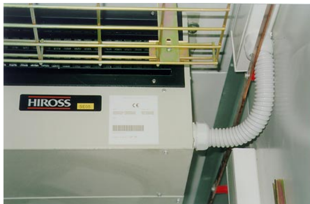
Fig. F – Détail des branchements électriques sur SE avec guide-câble et gaine en plastique (non fournis par nous)
