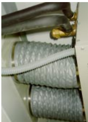
Abb. C – Freecooling–Leitungen
