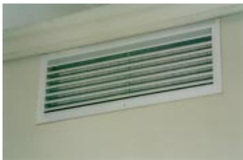
Fig. D – Grille externe antipluie avec préfiltre, qui peut être inspectée
