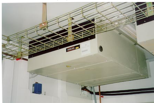
Fig. A – Unità evaporante SE
