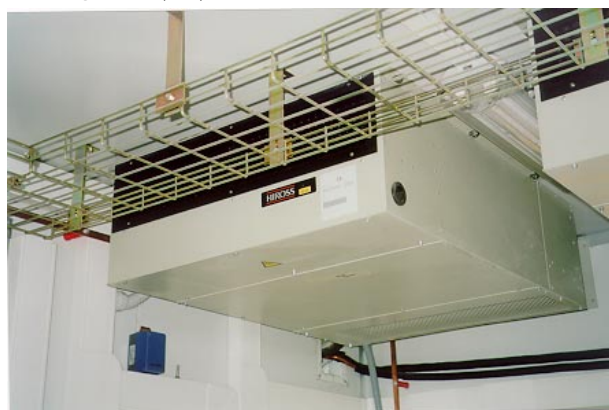
Fig. A – Evaporating unit SE
