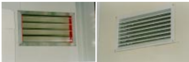
Fig. E – Rideau de surpression interne avec ouverture des ailettes vers l'extérieur et grille externe antipluie/antioiseaux correspondante
