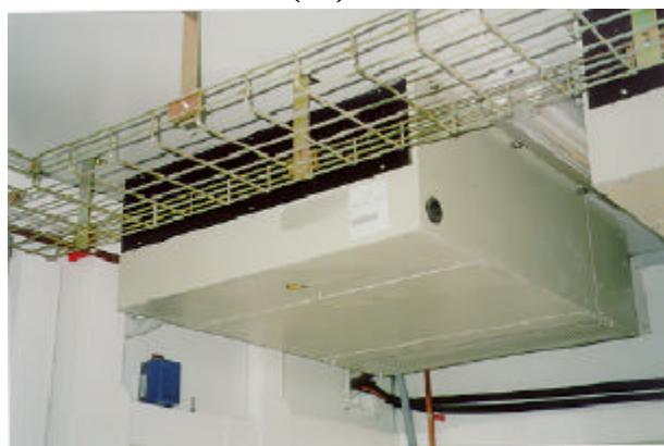
Fig. A – Equipo de evaporación SE
