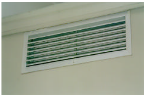
Fig. D – Griglia esterna anti-pioggia ispezionabile con prefiltro
