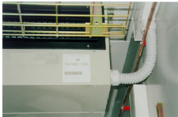
Fig. F – Detalle de las conexiones eléctricas del SE con fijador de cables y funda de plástico (no suministrado para nosotros)
