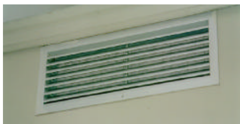
Abb. D – Äußeres, kontrollierbares Regenschutzgitter mit Vorfilter
