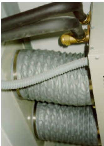
Abb. C – Freecooling–Leitungen
