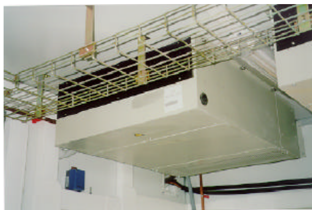
Fig. A – Unità evaporante SE
