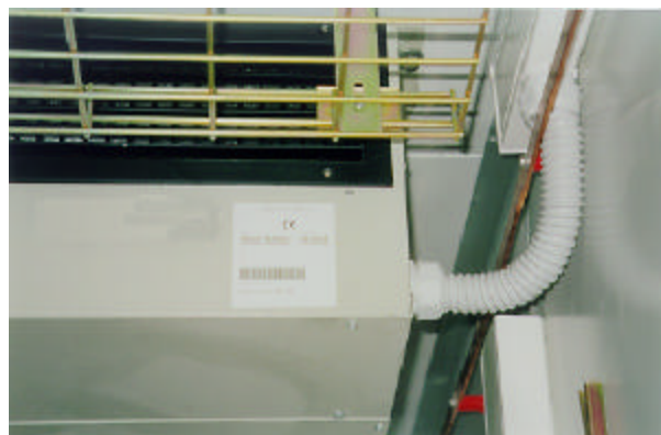
Fig. F – Dettaglio delle connessioni elettriche ad SE con pressacavo e guaina plastica (non forniti da noi)
