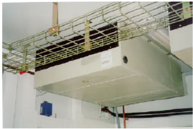
Fig. A – Equipo de evaporación SE
