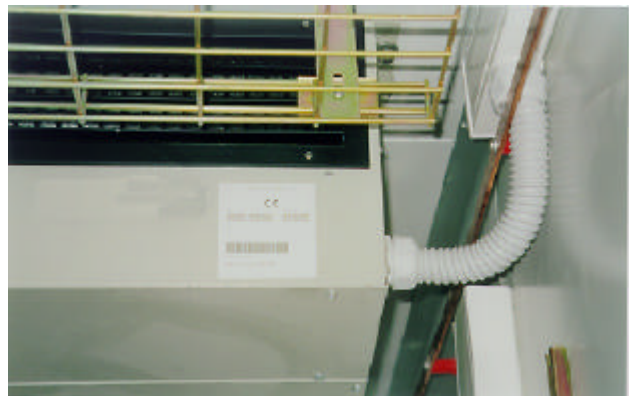
Fig. F – Detalle de las conexiones eléctricas del SE con fijador de cables y funda de plástico (no suministrado para nosotros)
