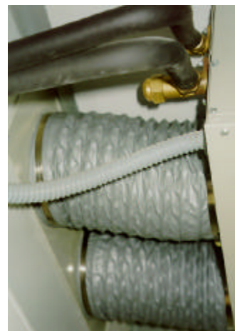
Abb. C – Freecooling-Leitungen
