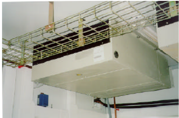
Fig. A – Evaporating unit SE
