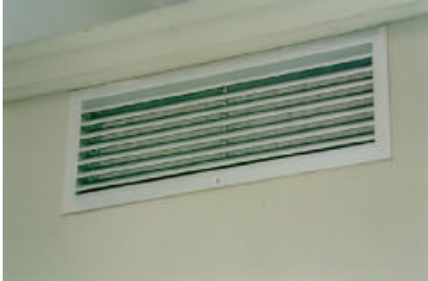
Fig. D – Grille externe antipluie avec préfiltre, qui peut être inspectonnée
