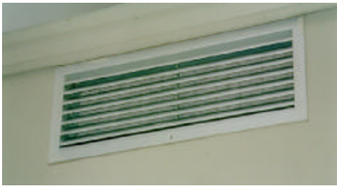
Fig. D – Griglia esterna anti-pioggia ispezionabile con prefiltro
