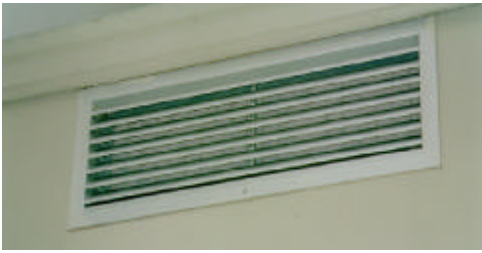
Abb. D – Äußeres, kontrollierbares Regenschutzgitter mit Vorfilter
