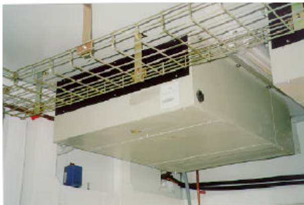
Fig. A – Unità evaporante SE
