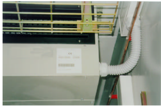
Abb. F – Detailansicht der elektrischen Anschlüsse an SE mit Kabelpresse und Kunststoffhülse (nicht bei uns geliefert).
