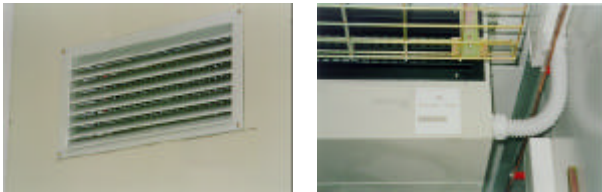
Fig. E – Rideau de surpression interne avec ouverture des ailettes vers l'extérieur et grille externe antipluie/antioiseaux correspondante
