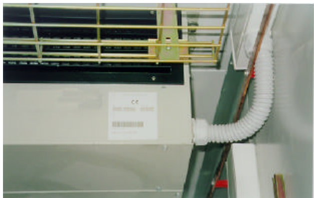
Fig. F – Dettaglio delle connessioni elettriche ad SE con pressacavo e guaina plastica (non forniti da noi)
