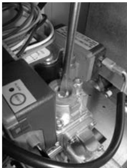
Überprüfen und justieren Sie ggf. den **AUSTRITTS**DRUCK des Ventils auf 8,4 mbar (G20) / 12,3 mbar (G25) für L-Gas und 31,4 mbar (G31) für Propangas (Abbildung 53).
