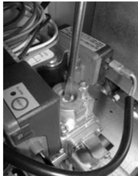
Überprüfen und justieren Sie ggf. den Ventil-austrittsdruck auf 8,4 mbar (G 20) (oder 12,3 mbar für G25) (Abb. 83).
