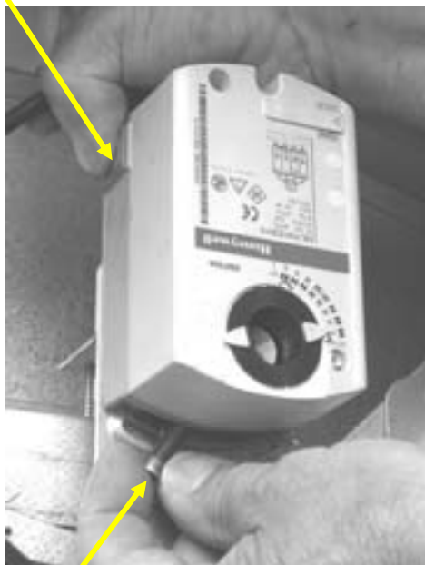
Rotation manuelle du servomoteur
