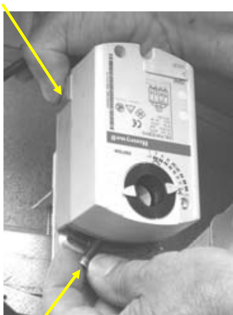
Handmatige rotatie van de aandrijving
