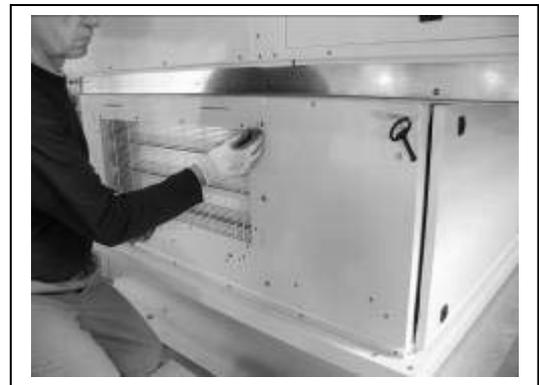
Die beiden Dreieck-Seiten von der Haube nehmen ebenso wie die drei letzten Schrauben, die der Befestigung des Rahmens der Wärmerückgewinnung dienen.
