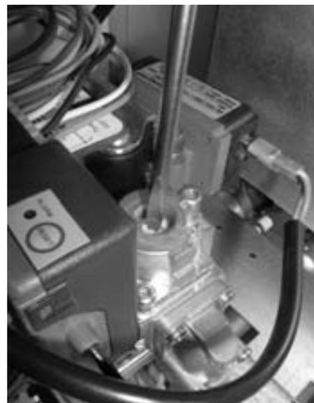
Überprüfen und justieren Sie ggf. den **AUSTRITTS**DRUCK des Ventils auf 8,4 mbar (G20) / 12,3 mbar (G25) für L-Gas und 31,4 mbar (G31) für Propangas (**Abbildung 53**).
