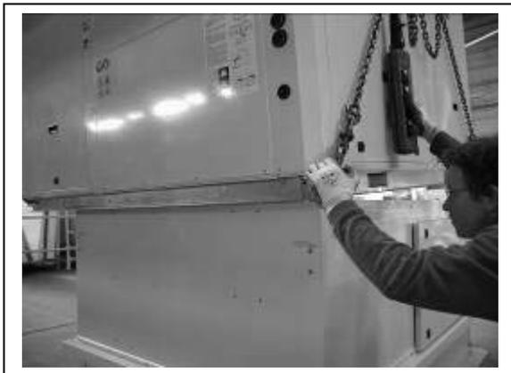
Zunächst die schwere Seite (Verdichterseite) aufsetzen dann zurechtrücken.
