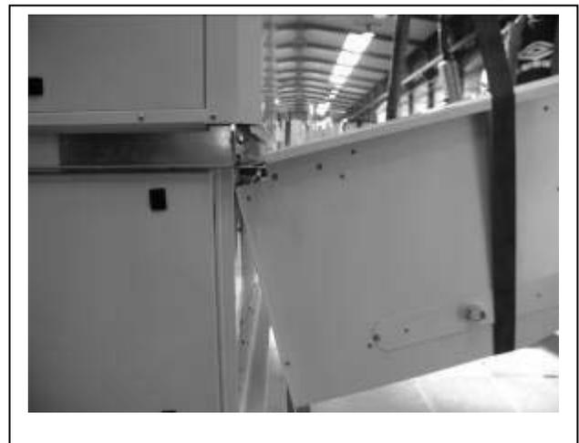
Den Rahmen (mittels eines Krans oder von Hand) in die Nähe des Rooftops bringen. Die obere Biegung muss in die rechteckigen Schlitze am Rahmen passen.
