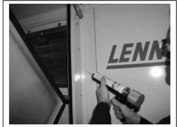
An der Dachseite und an den Flanschseiten sehr sorgfältig auftragen.
