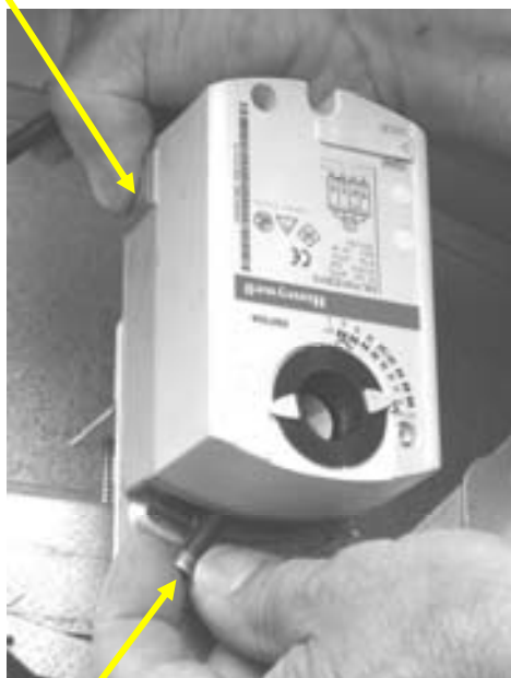
Rotation manuelle du servomoteur
