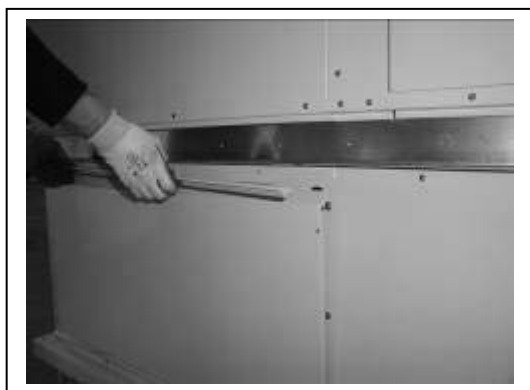
Couper l'élément d'étanchéité de la cornière supérieure de la casquette et retirer la cornière.
