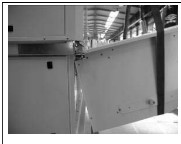
Amener le support (au moyen d'une grue ou manuellement) à proximité du Rooftop. L'élément coudé supérieur doit s'insérer dans les rainures rectangulaires du châssis.
