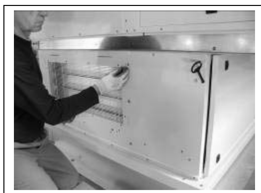
Relever les 2 triangles latéraux de la casquette et dévisser les 3 dernières vis qui serviront à fixer le support de l'échangeur de chaleur.
