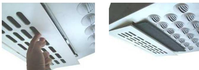
Engager un tournevis à travers une ouverture et insérer le dans un trou prévu à cet effet, puis incliner l'une des faces latérale de la porte vers l'intérieur pour dégager l'argot de retenue.
