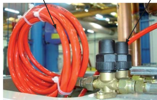
Hogedrukleidingen klaar voor aansluiting op het ventiel
